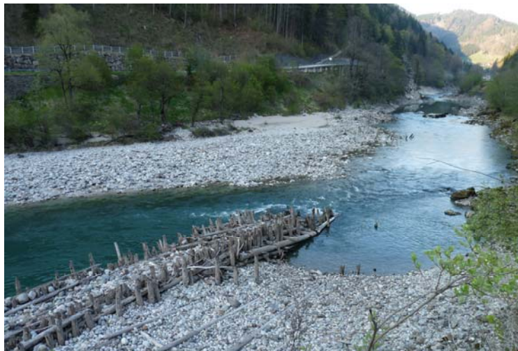
Pilotenreste des Gasteiger Rechens in der Enns
